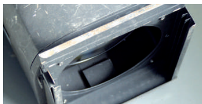
Les PC et les découpes possèdent un système multi-glissière dont l'écartement ne permet pas une convection suffisante de plusieurs filtres.
